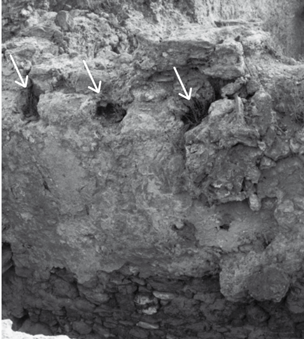
Fig. 9a : Détail d'un mur du Palais royal recouvert d'un enduit de pisé, avec emplacement des poutres en bois qui supportaient le plafond (aujourd'hui disparu) (cliché, archives de la mission, infographie N. Vernay).
